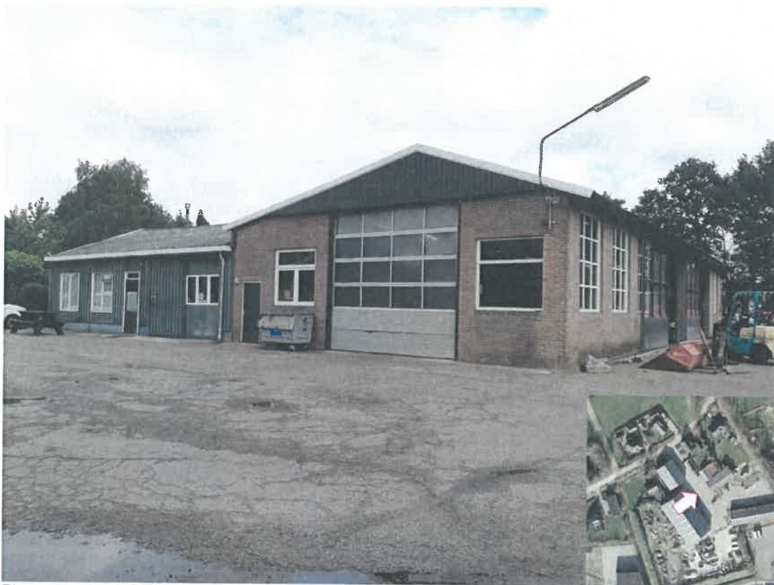
Zicht op werkplaats / Kantine
