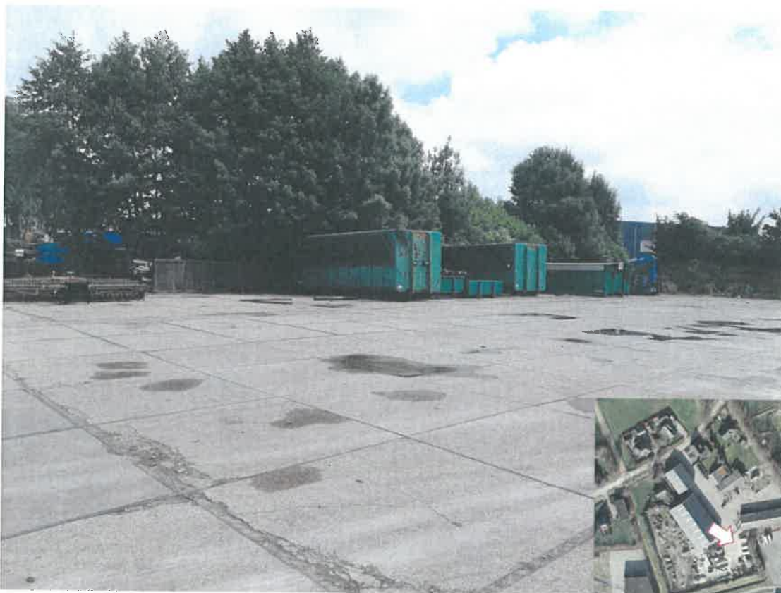
Opslag in containers en ernaast
