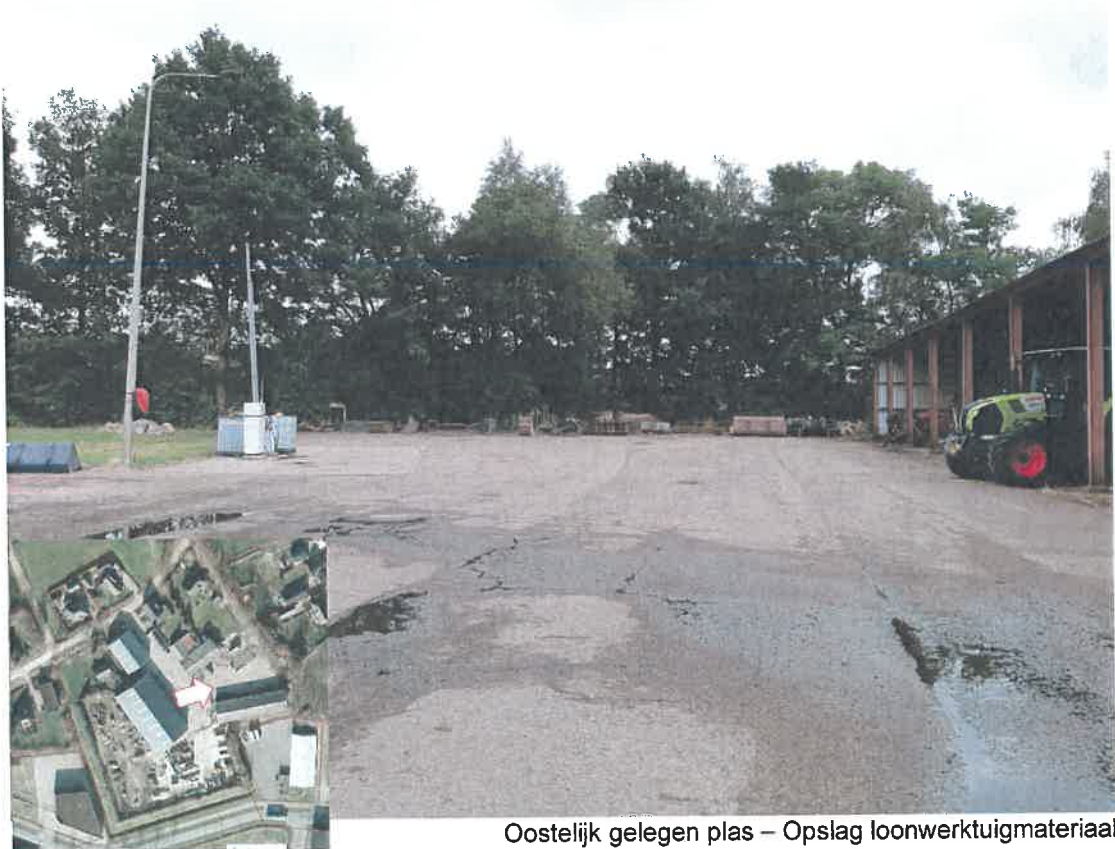
Oude schuur – Stalling loonwerkvoertuigen
