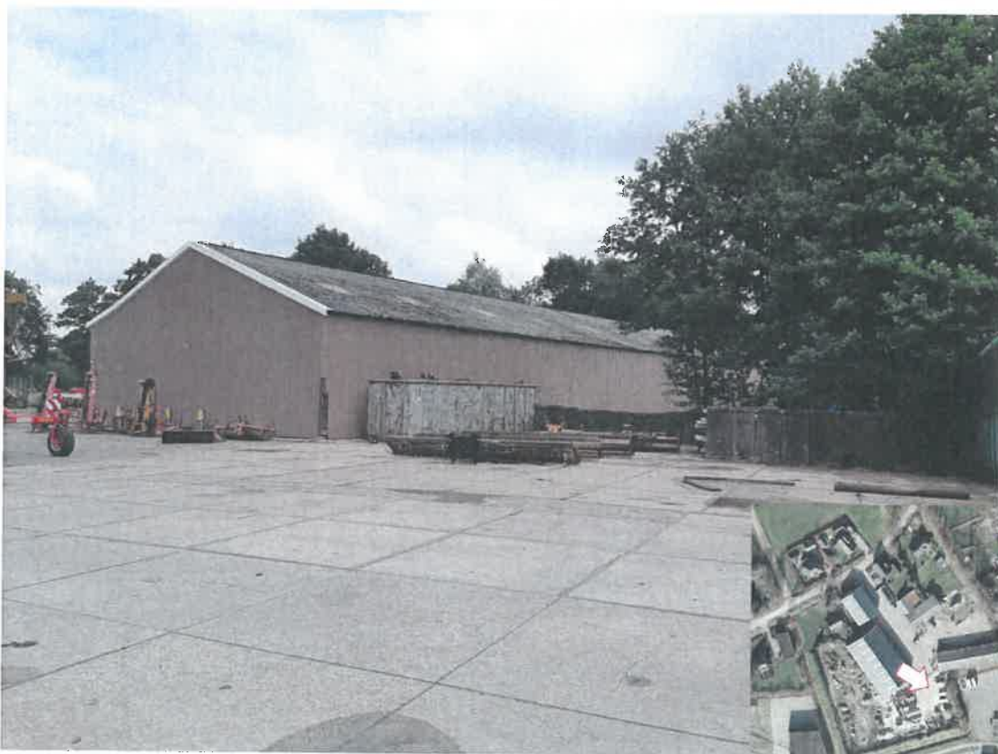
Achterzijde oude stalling schuur – Stalling loonwerktuigmateriaal
