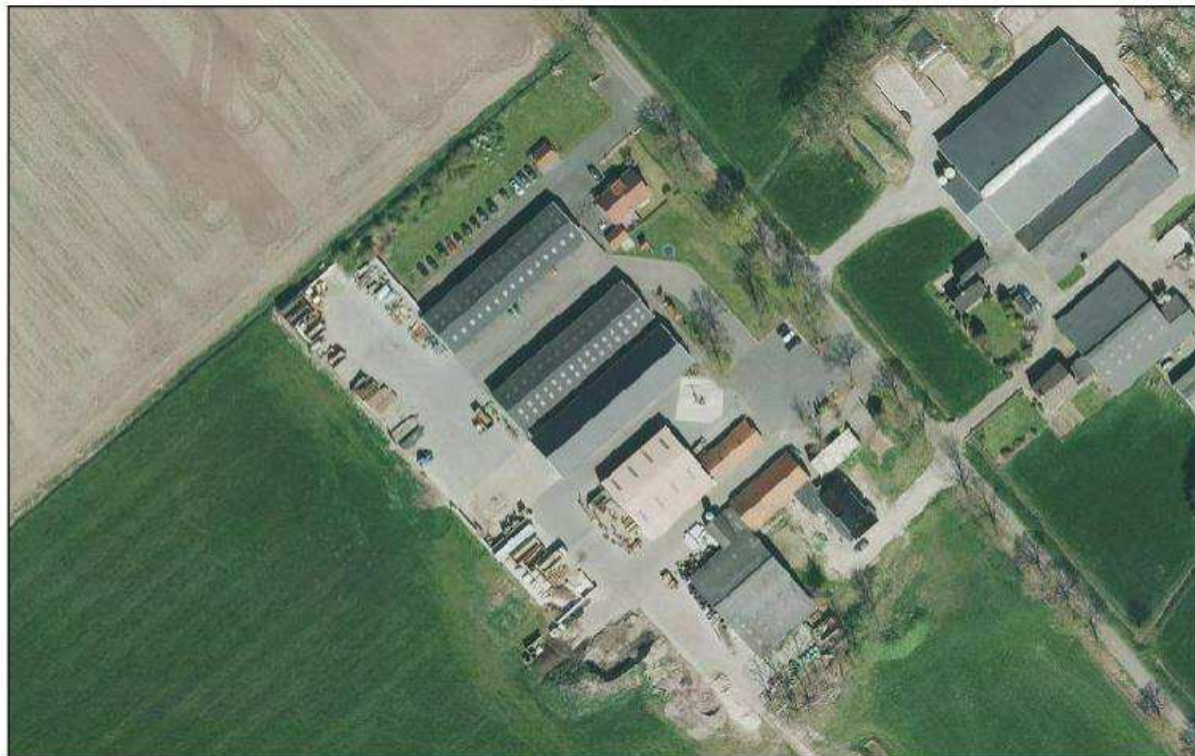
Afbeelding 3: Luchtfoto van het projectgebied (Bron: Provincie Overijssel)
