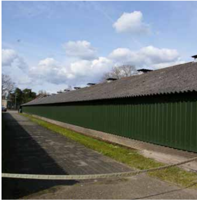
De pluimveestallen worden gesloopt
