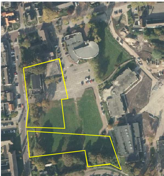
Detailopname van het plangebied. Bron: Google Maps. De op luchtfoto aanwezige bebouwing was tijdens het onderzoek reeds gesloopt.
