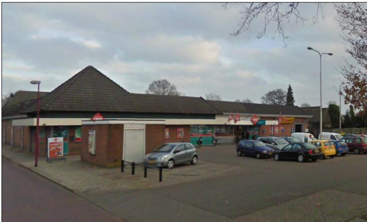
Figuur 2.4 Straatbeeld huidige situatie ter plaatse van de uitbreidingslocatie (Bron:Google Streetview)
