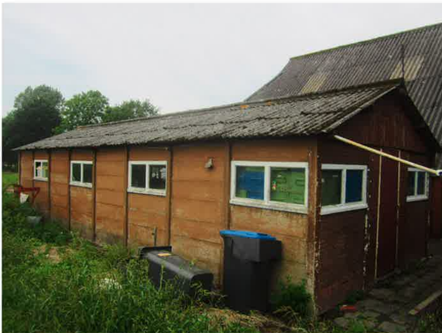
MM 2 Foto 9, Asbesthoudende golfplaten en hulpstukken op het dak van de schuur.
