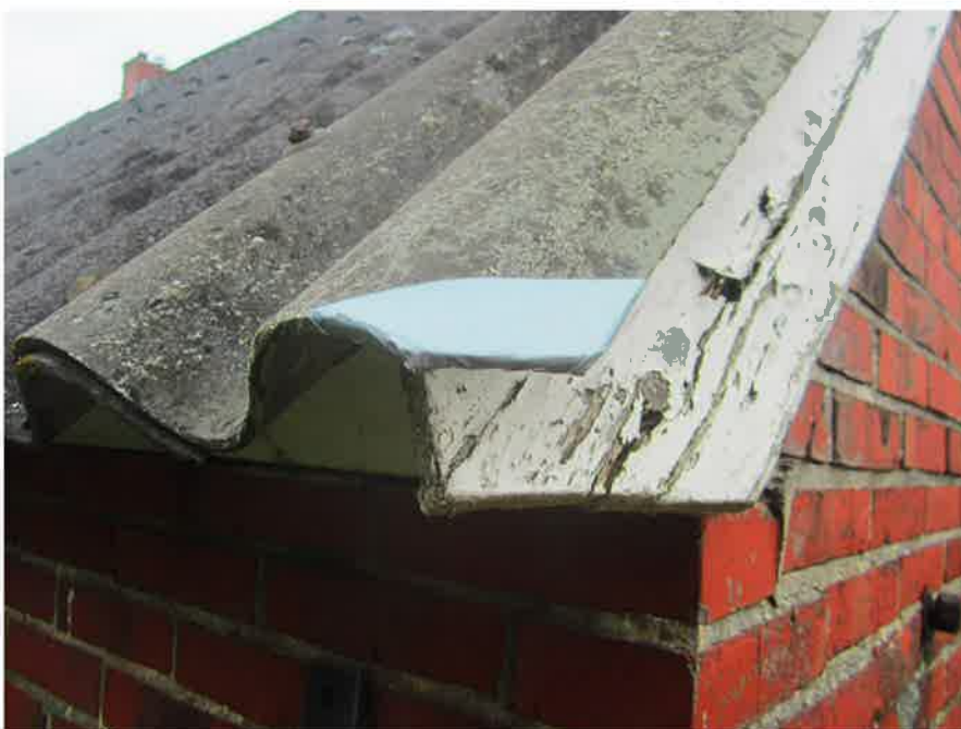
MM 1 Foto 2, Asbesthoudende golfplaten en hulpstukken op het dak van de boerderij, detailfoto monsternamelocatie.
