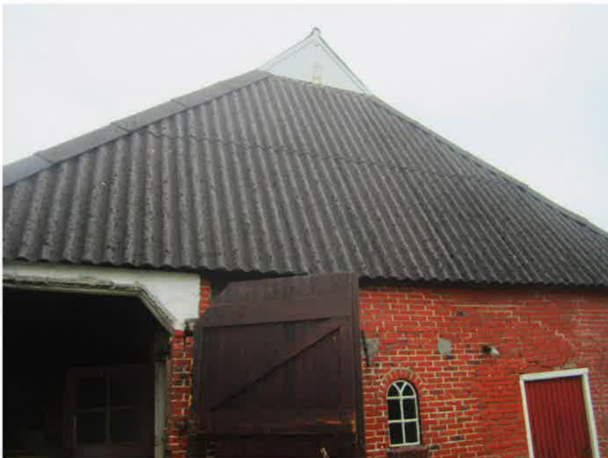
MM 1 Foto 3, Asbesthoudende golfplaten en hulpstukken op het dak van de boerderij.
