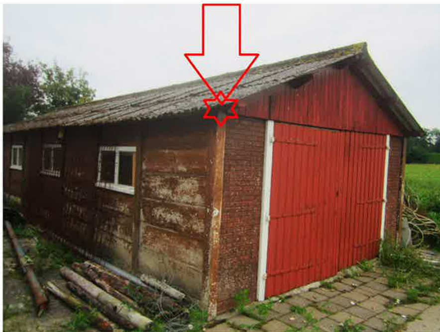
MM 2 Foto 7, Asbesthoudende golfplaten en hulpstukken op het dak van de schuur, overzichtsfoto monsternamelocatie.
