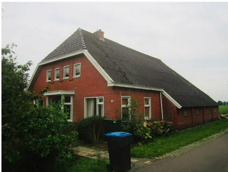
MM 1 Foto 5, Asbesthoudende golfplaten en hulpstukken op het dak van de boerderij.
