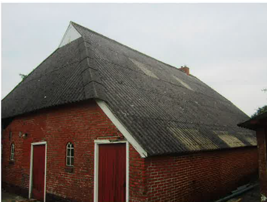
MM 1 Foto 4, Asbesthoudende golfplaten en hulpstukken op het dak van de boerderij.
