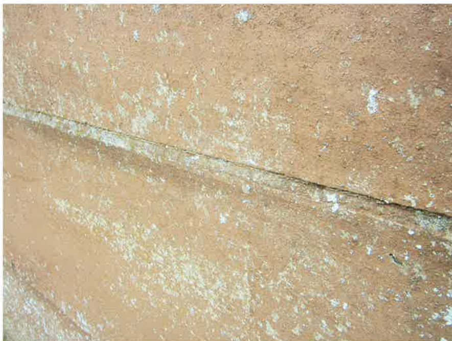
Foto 11, Detailfoto van de betonnen gevelelementen van de schuur met een voeg van cement.
