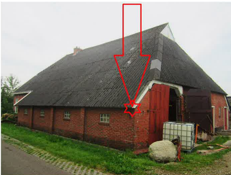
MM 1 Foto 1, Asbesthoudende golfplaten en hulpstukken op het dak van de boerderij, overzichtsfoto monsternamelocatie.
