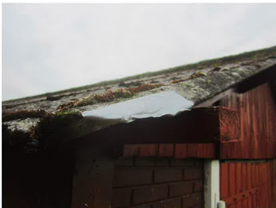
MM 2 Foto 8, Asbesthoudende golfplaten en hulpstukken op het dak van de schuur, detailfoto monsternamelocatie.
