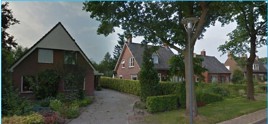
Zicht op ten noorden gelegen woningen
