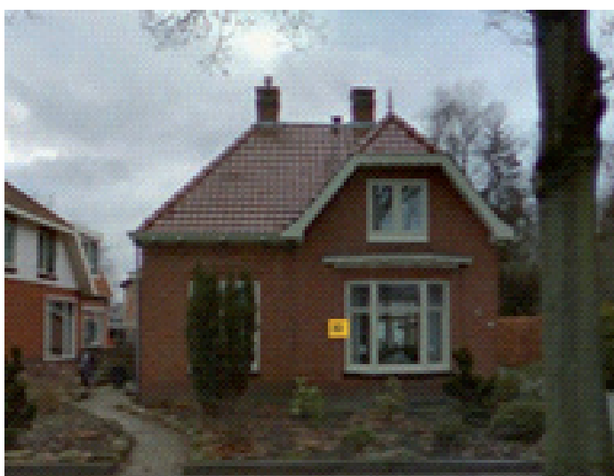
Leeksterweg 30 Ca 1925 Eenvoudige Interbellumarchitectuur met elementen van de Overgangsstijl (dakbedekking)
