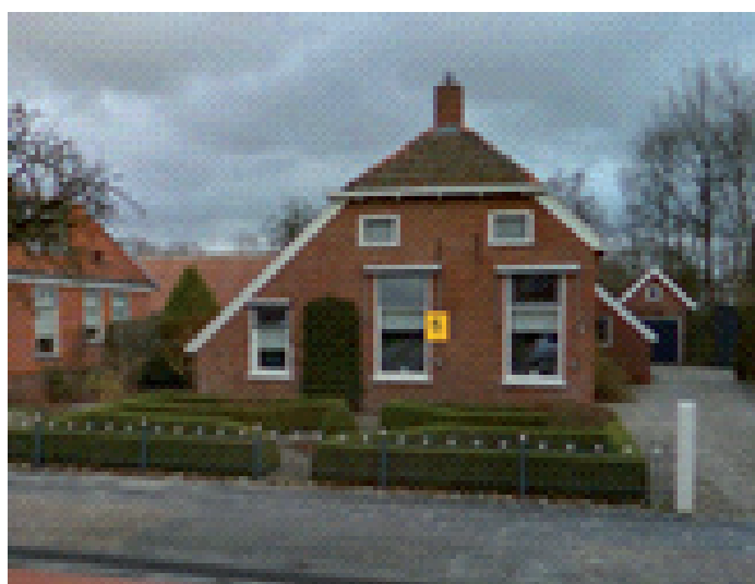
Groningerstraat 5 zeldzaam voorbeeld van keuterboerderij binnen de bebouwde kom van Roden en als onderdeel van ensemblebescherming Groningerweg 3 t/m 9 en Groningerweg 18/20
