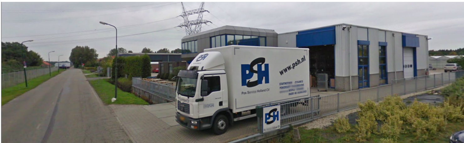
09 - beeld vanaf de Stichtse Kade - bedrijfsgebouw op nummer 47c - achter het bedrijfsgebouw is de nieuwbouw gepland
