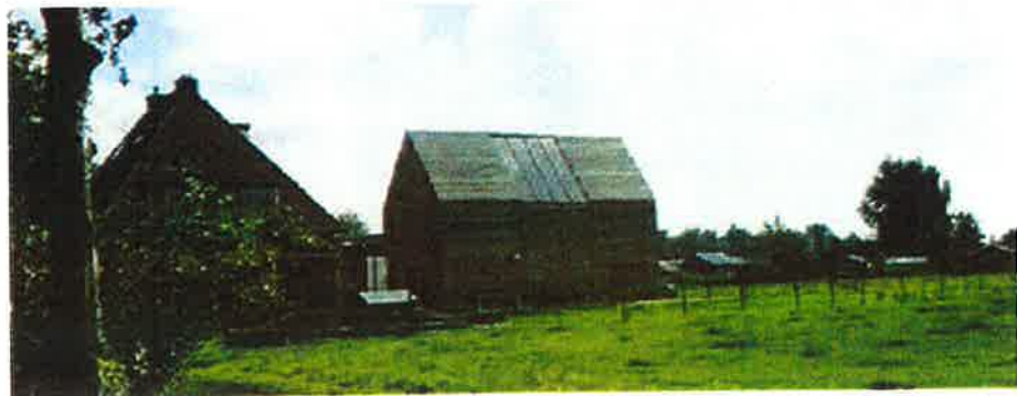
Glas geïntegreerd in kap en gevel aan zuidzijde
