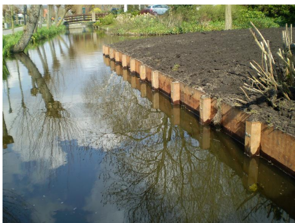
Eenvoudige beschoeiing haventje sloepen
