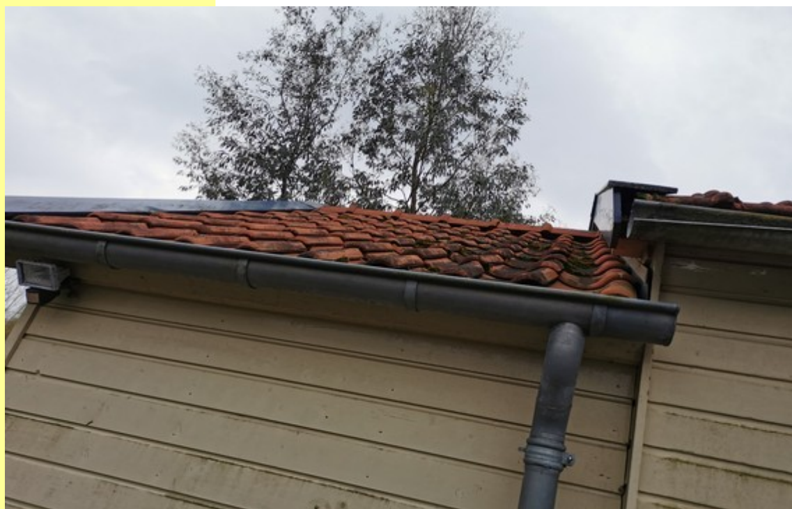
Bolle dakpannen bij recreatiewoning (nr. 6b)
