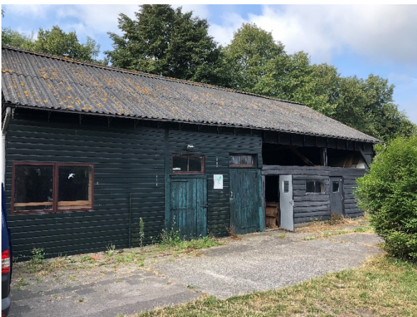
'asbestverdacht dak'
