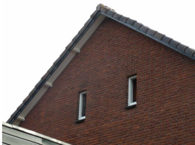
Figuur 15: Potentiele locatie vleermuiskast noordgevel
