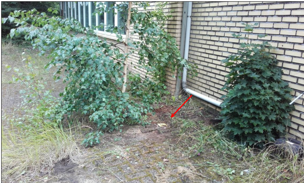
Figuur 3: Peilbuis W100 ter plaatse van voormalig boorpunt 1027
