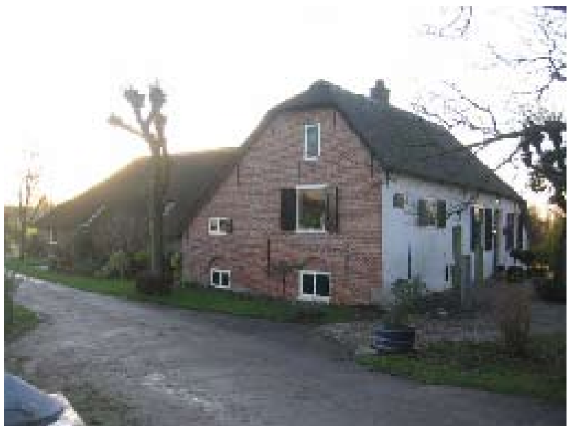
Deze prachtige boerderij heeft heel verschillende gevels, in vorm, materiaal en richting; 1 van de kopgevels staat gedraaid ten opzichte van de hoofdrichting van de kap
