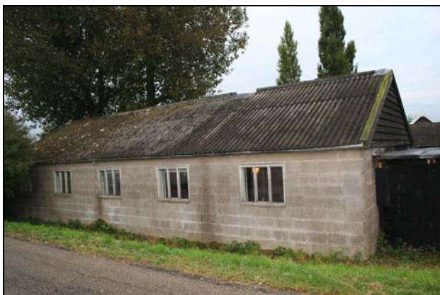
Figuur 1: Er is ten tijde van het veldbezoek een gewone dwergvleermuis waargenomen ter hoogte van het golfplaten dak van de bewoonde ruimte.
