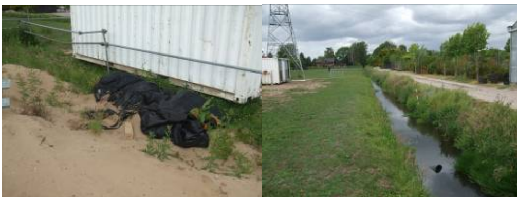
Figuur 4.7 Aanwezige schuilgelegenheden in de vorm van rommelhoekjes in het plangebied en geschikt voortplantingswater ten noorden van het plangebied.
