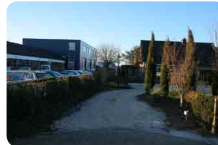
wisselende korrelgrootte en functie bebouwing
