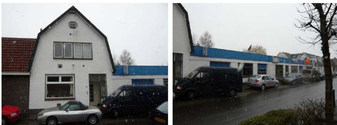
Figuur 2.1 Bestaande situatie
