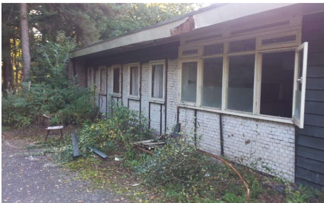
Verwijderen gepotdekselde betimmering
