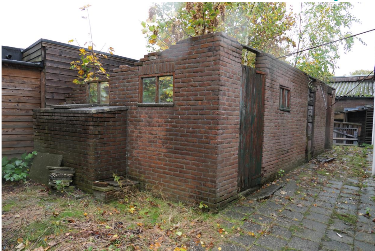
Afbeelding 2.6 Opslagschuur noordzijde projectgebied.
