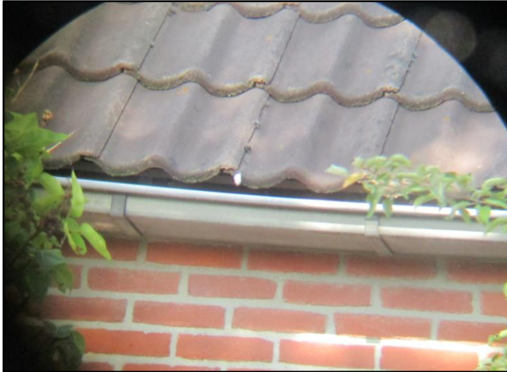
Figuur 4 De dakruimte van het woonhuis en schuur aan de Voederheil 16 te Zeeland is toegankelijk vanuit de dakgoot
