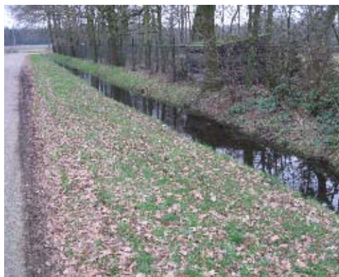
Sloot aan westzijde perceel
