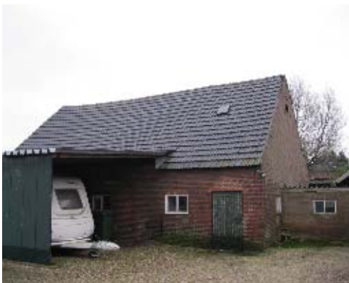
Achterzijde van het te slopen gebouw
