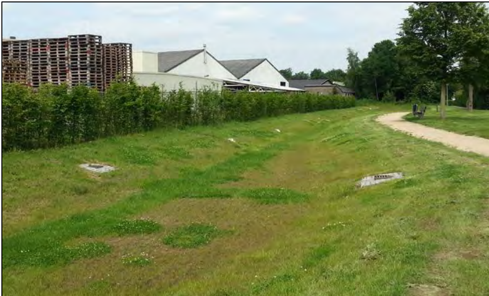
Afbeelding 9: foto aangelegde wadi [bron: voorbeeld aanleg wadi gebr. de Ronde Beusichem]
