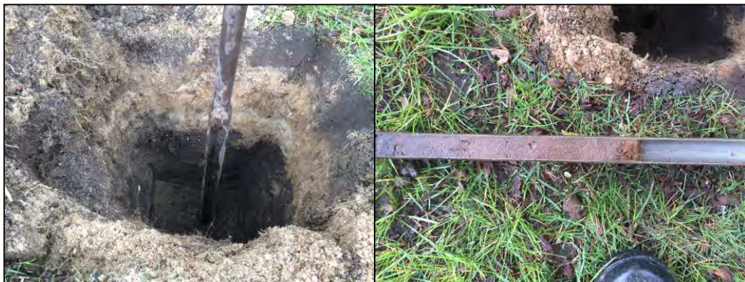
Figuur 9: Opname van het kijkgat bij boring 4.
