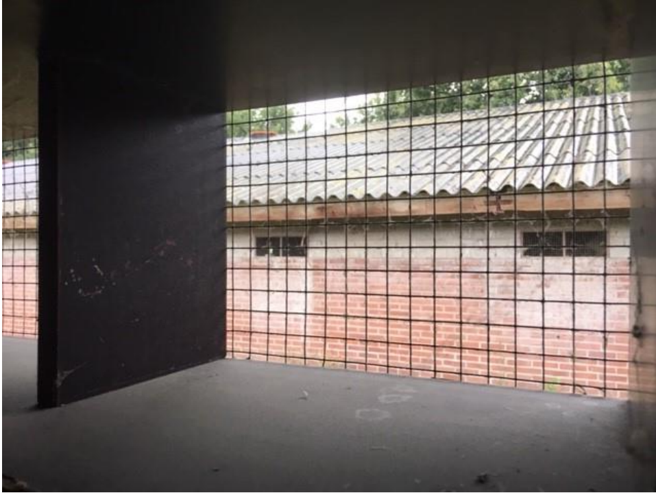
• Afbeelding 22: luchtinlaatventielen met vogelgaas
