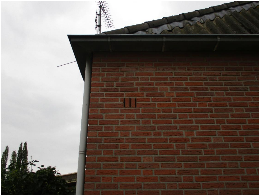
Figuur 2 Ventilatioorosters in het voormalige tuincentrum, wegens na-isolatie geen verblijfplaatsmogelijkheden voor vleermuizen.
