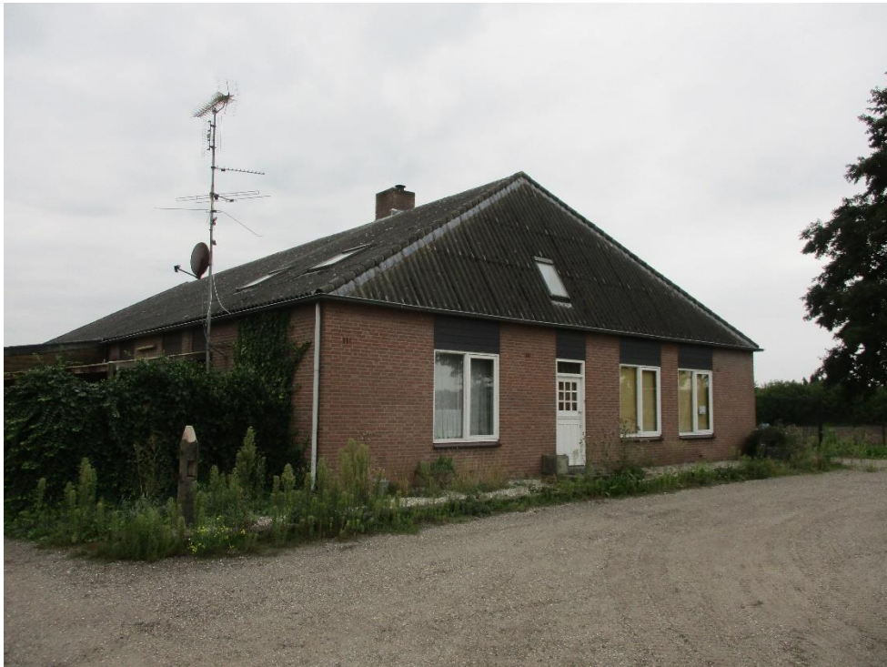
Figuur 1 Het te saneren gebouw bestaat uit een gemetselde, geïsoleerde spouwmuur met een zadeldak met golfplaten.
