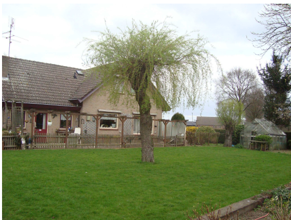
Figuur 4: Foto achterzijde woning 1
