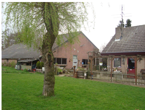
Figuur 5: Foto achterzijde woning 2
