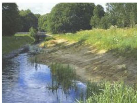
Waterloop met flauw talud
