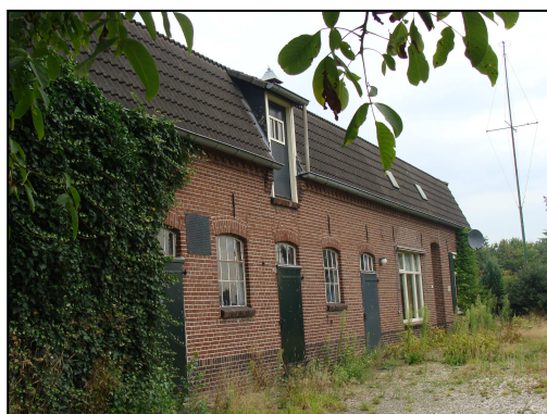
Foto 3. Woonhuis en aangrenzende stal
