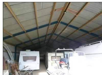
Figuur 9. Binnenzijde loods.
