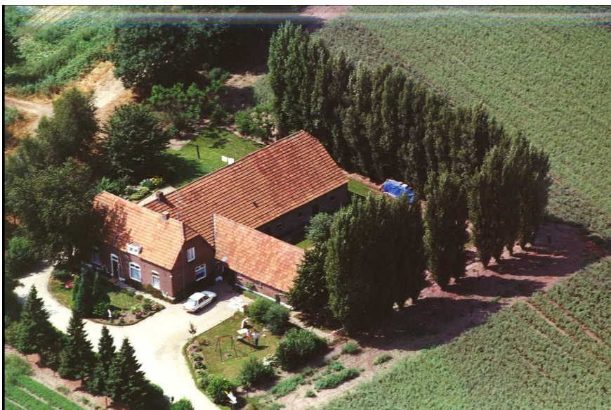
luchtfoto uit 1996 van de Steenakker met linksboven de spoordijk
