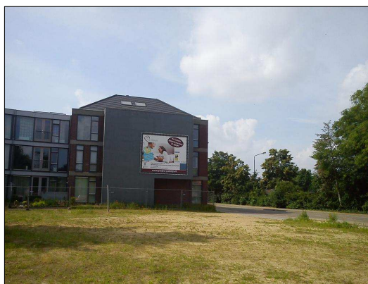
Zicht op de bestaande bebouwing aan de zuidkant van het plangebied, met op de voorgrond het braakliggende plangebied.
