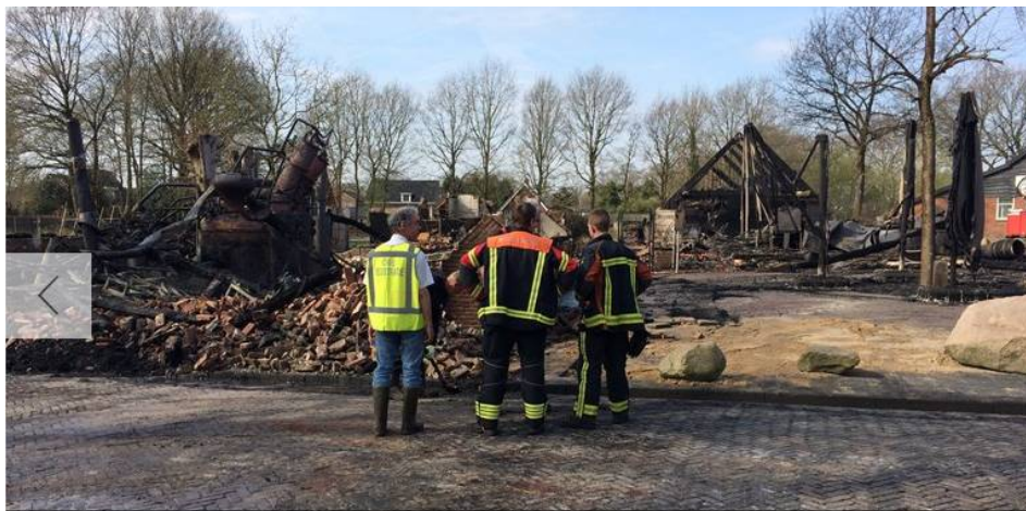
Afbeelding 7: Het Bebinghehoes na de brand in 2017, gezien vanaf de Zuiderhoofdstraat. Bron: RTV Drenthe
