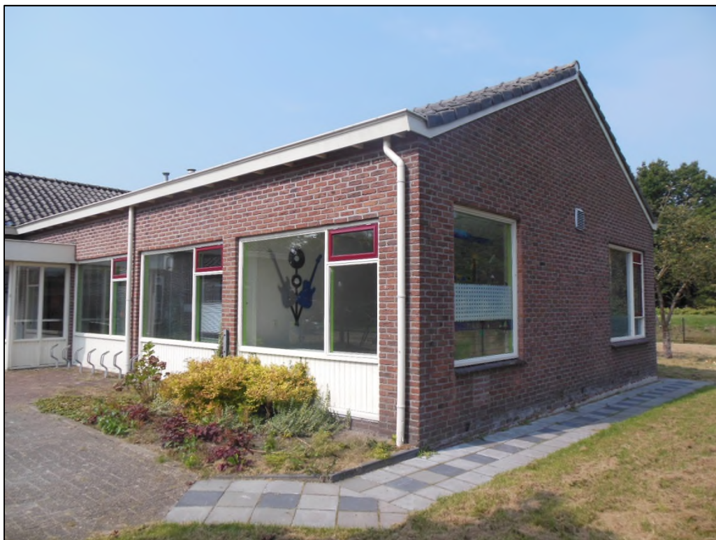
Voorgevel en rechter zijgevel
