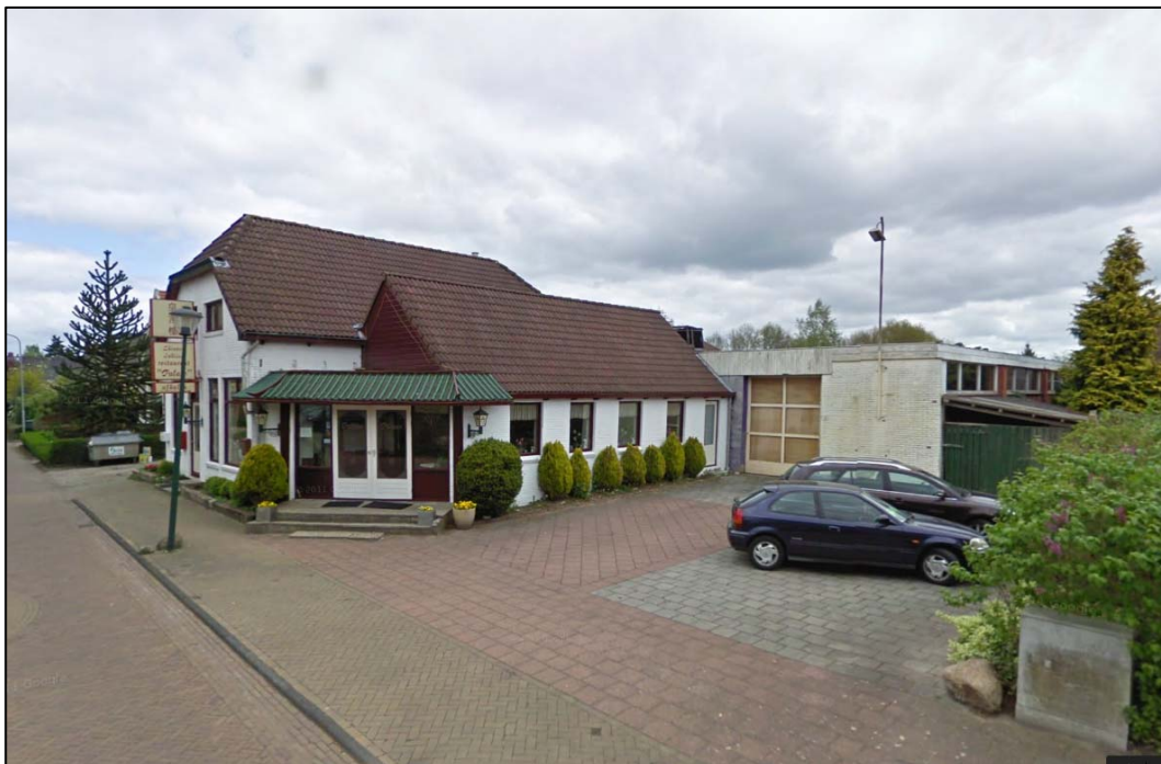
Voormalig restaurant en bedrijfsloods op het perceel Ambachtsstraat 2 voor de brand en sloop (bron: Google Streetview)
