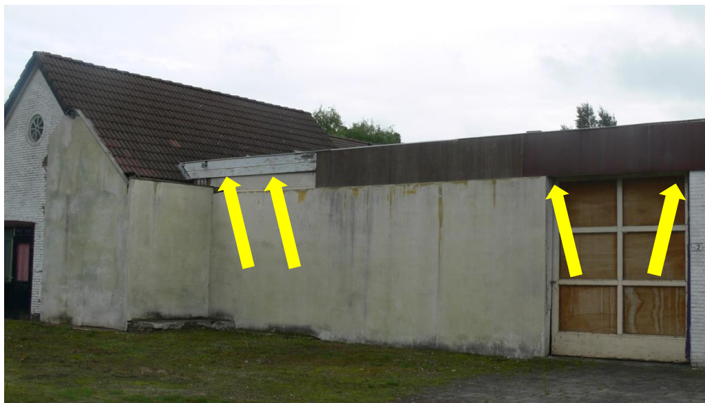
Figuur 3 Voorbeelden van potenties voor vleermuisverblijfplaatsen in de loods aangegeven met gele pijlen.
