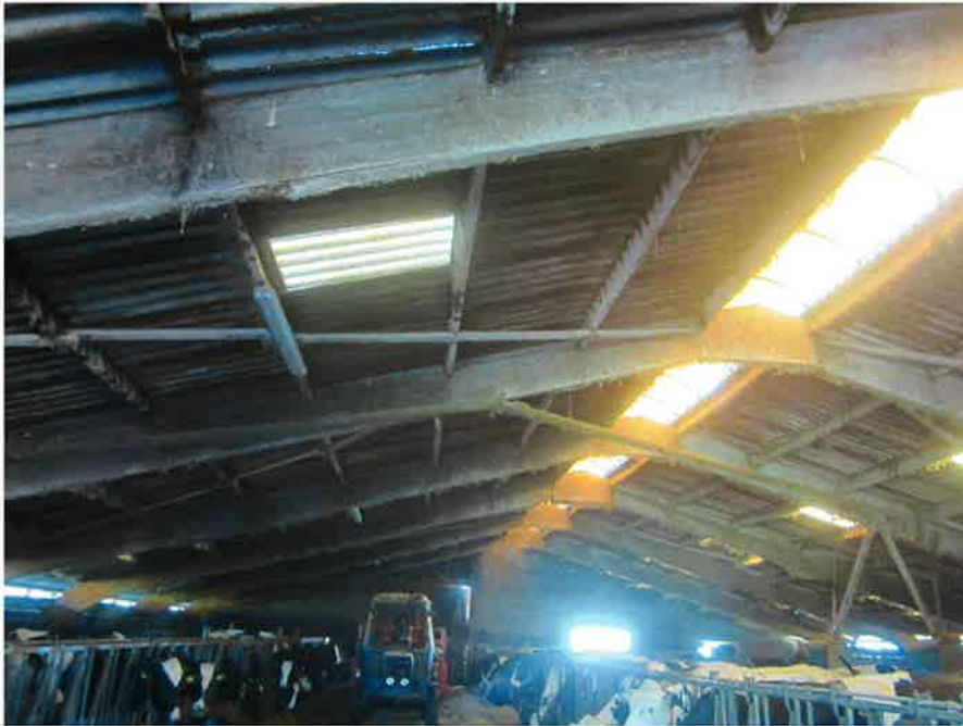
MM 1 Foto 5, Asbesthoudende golfplaten en hulpstukken op het dak van de stal.
