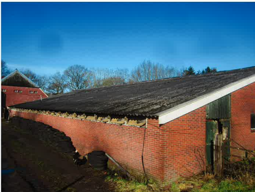
MM 1 Foto 4, Asbesthoudende golfplaten en hulpstukken op het dak van de stal.
