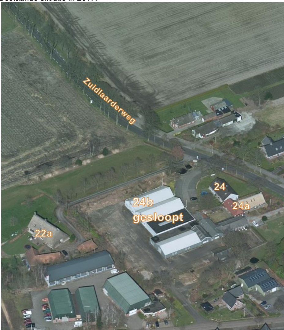
Bestaande situatie in 2018.
