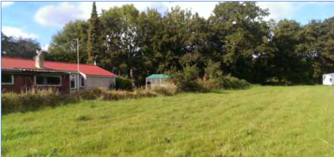
Figuur 2 Impressie van het te slopen huisje en een deel van de nieuwbouwlocatie daarnaast
