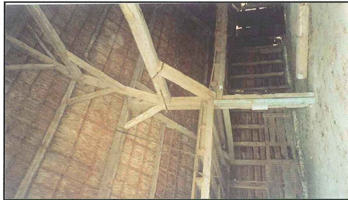
Foto 7: Dubbele ankerbalk gebinten in grote schuur (A)
