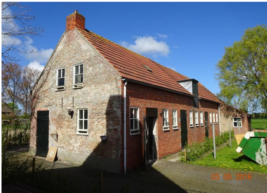
Afbeelding 7 - Voormalig agrarisch bedrijfsgebouw; de oostelijke gevel (met restant pleisterwerk) bevat nog grote delen metselwerk uit de achttiende eeuw; dit is plaatselijk gerepareerd; de noordelijke gevel en de kozijnen zijn in de wederopbouwperiode gerepareerd/opnieuw opgebouwd. De bewogen geschiedenis van het gebouw is nog duidelijk afleesbaar.
