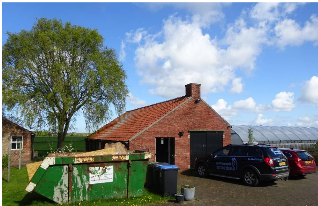
Afbeelding 8 - voormalig agrarisch bedrijfsgebouw; duidelijk herkenbaar al bouwwerk uit de wederopbouwtijd in traditionalistische landelijke stijl; rechts is de af te breken teeltondersteunende voorziening zichtbaar.
