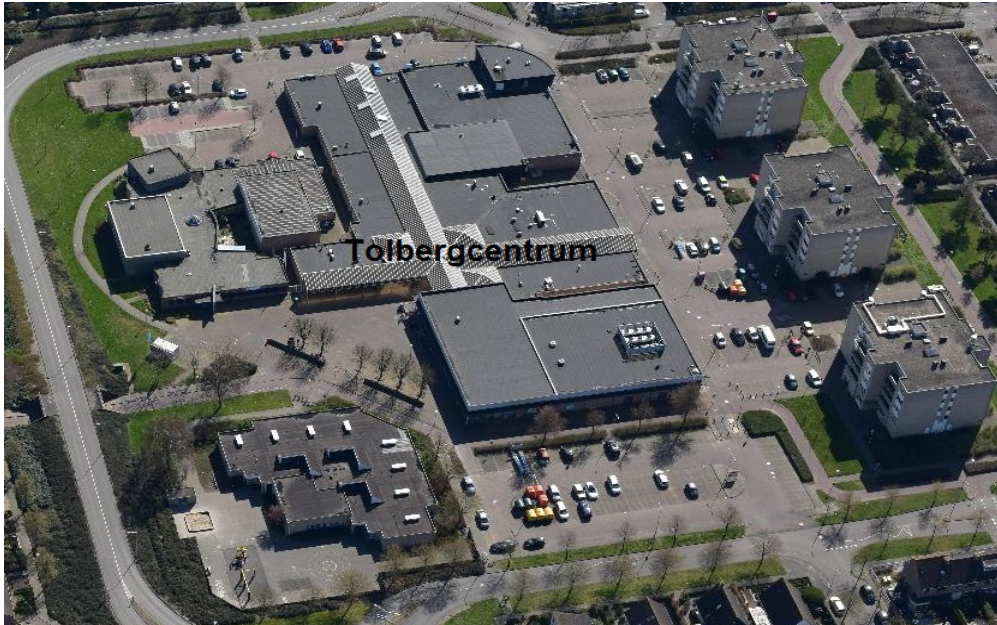
Bovenaanzicht Tolbergcentrum (Slagboom en Peeters)
