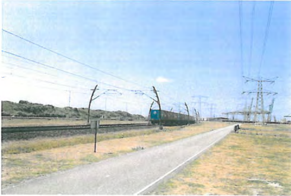
Figuur 25 Havenspoorlijn in westelijke richting. De trein rijdt op het dichtstbijzijnde spoor.
