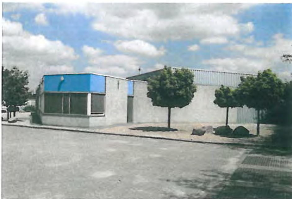
Figuur 21 Foto zijkant pand aan de spoorzijde, camerapositie 3.
