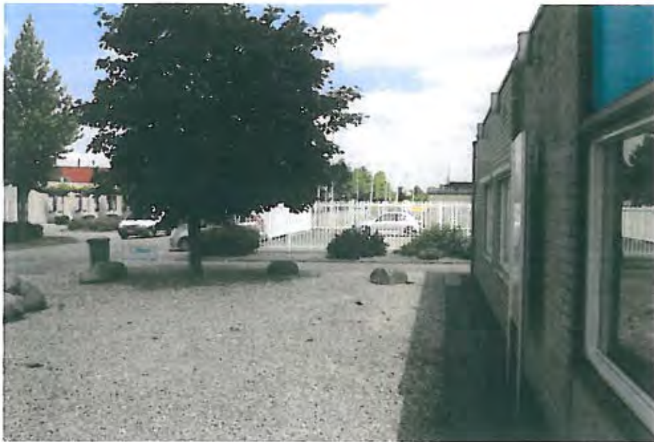
Figuur 19 Foto voorzijde pand, camerapositie 1. Rechts van de steen bij de hoek van het pand (midden foto) ligt opnemer 1_2.
