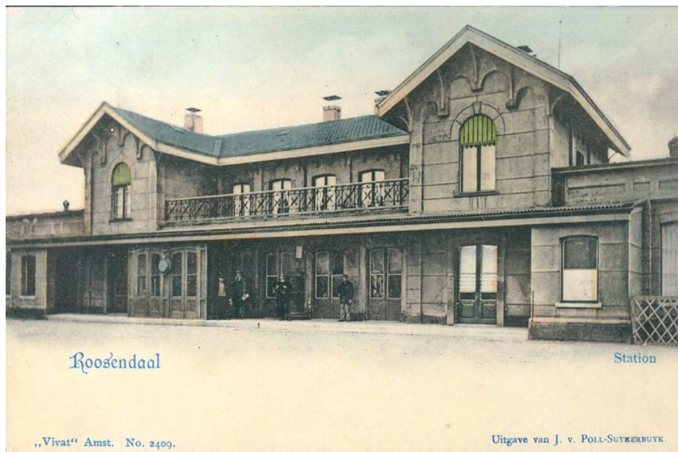
Station aan de Vughtstraat
