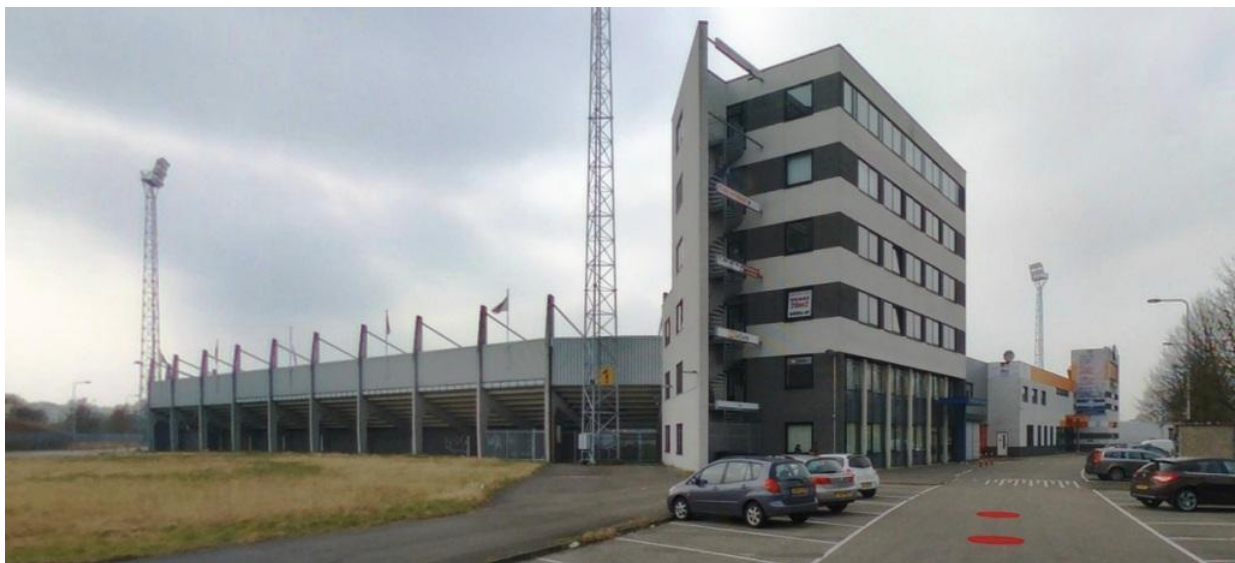
Stadion RBC: voor- en achterzijde
