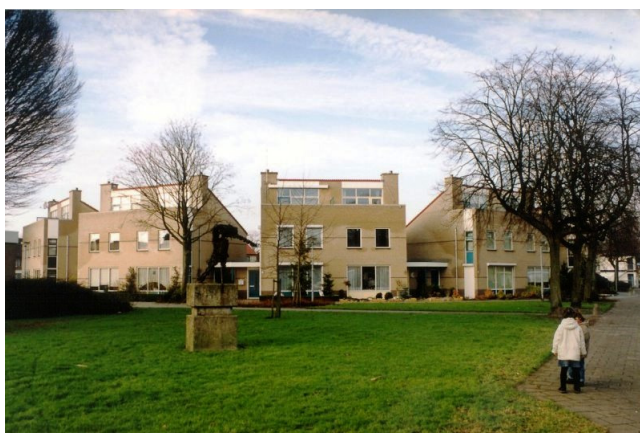
Woningbouw Carel Willinkplein
