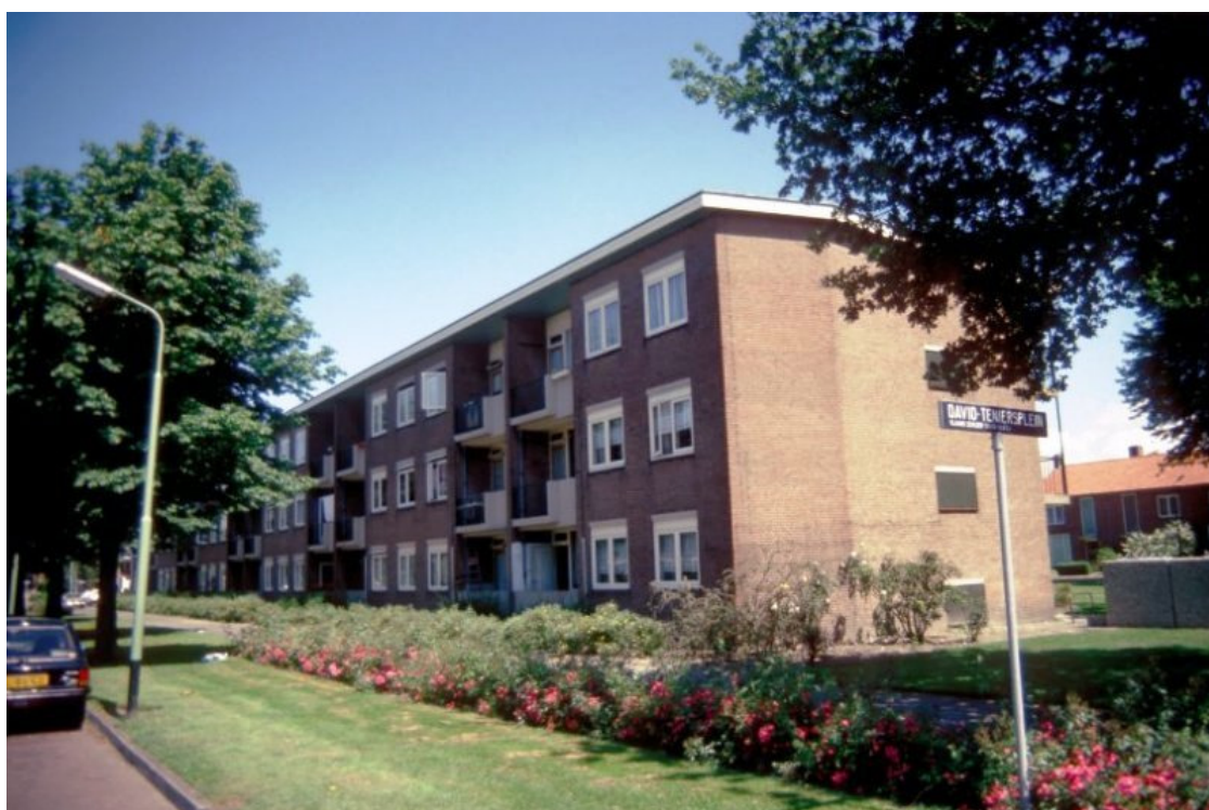
Etagewoningen aan de Rubenslaan
