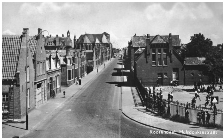
Zicht op Hulsdonksestraat vanaf viaduct A58 anno 1958
