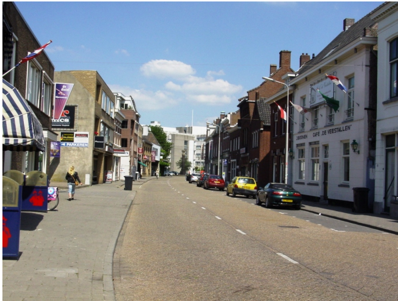
Zicht op de Kade: diversiteit in bouwkundige en functionele zin
