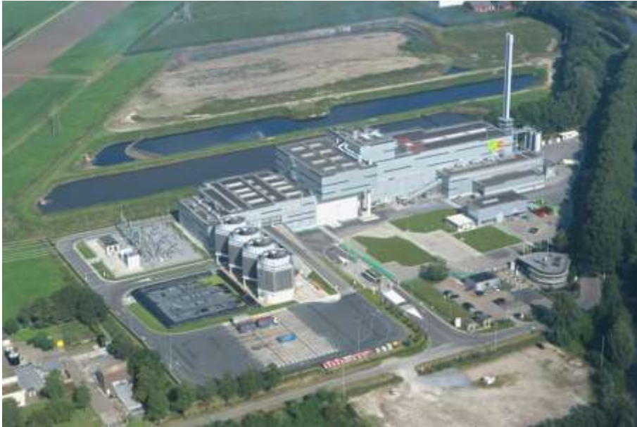
Afbeelding 24: SITA ReEnergy vanuit de lucht sinds 2011
