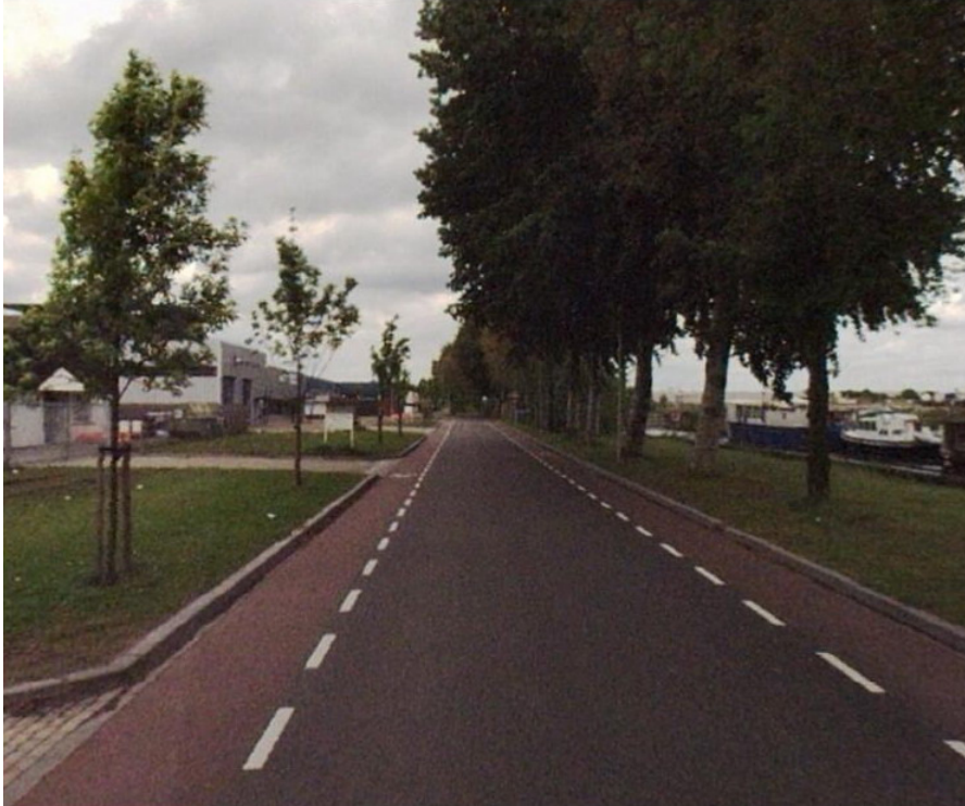
Foto 8: Westelijke Havendijk in de nieuwe situatie
