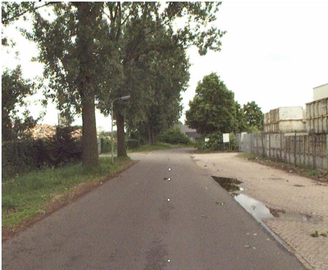
Foto 9: zuidelijk deel Bosstraat: niet berekend op het huidige gebruik
