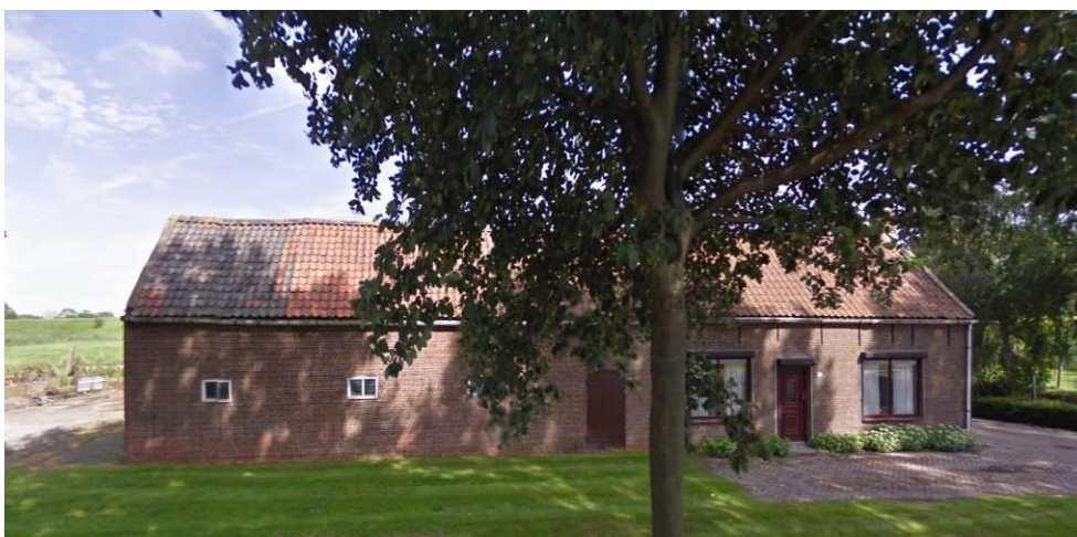
Afbeelding 5 - De voormalige boerderij - de agrarische bedrijfswoning vormt met aangebouwde stal een langevelboerderij; de ramen van het woonhuis zijn geruime tijd geleden vernieuwd en vergroot.
