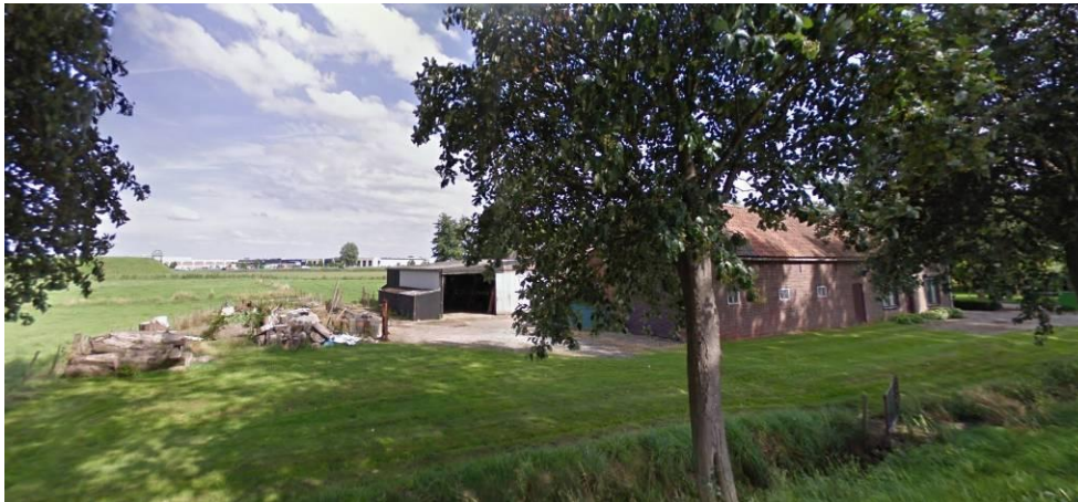
Afbeelding 6 - De voormalige boerderij vanaf het noordwesten. Een deel van de aanwezige, af te breken voormalige agrarische bedrijfsgebouwen is centraal zichtbaar. Op de achtergrond is het bedrijventerrein Borchwerf zichtbaar.
