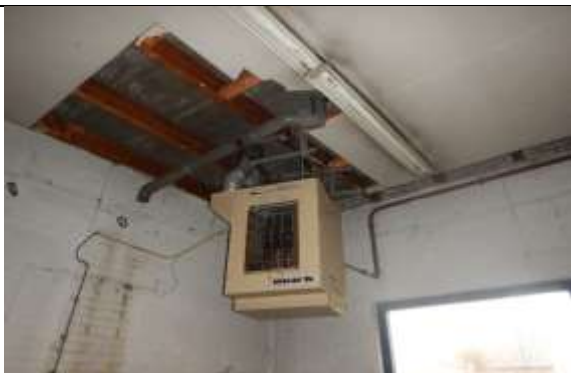
Mark heaters; niet asbestverdacht
