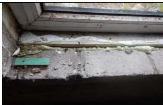
Kunststof kozijnen met kunststof stelplaatjes
