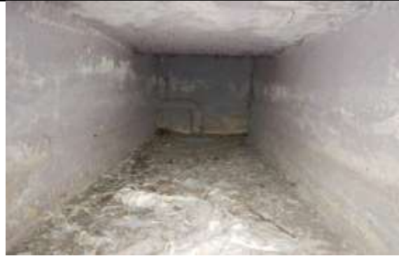
Gemetselde put met pvc riool
