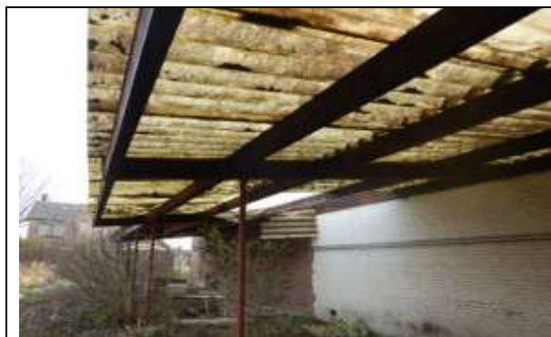
Afdak met lichtplaten
