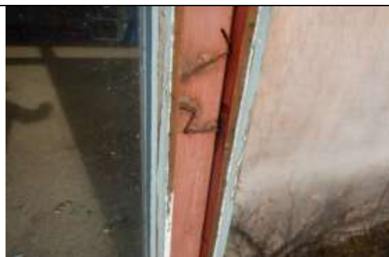
Stalen kolom tussen houten kozijnen
